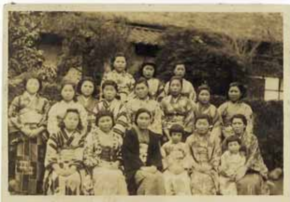
昭和18年頃、寿楽院庫裡の前でお針子達の記念写真です。中央に写っている寿楽院母堂も今年7月一周忌が過ぎたところです。庫裡前の坪庭が懐かしく思い出されます。この庫裡を屋根替えし、少し改造したのが現在のものです。
