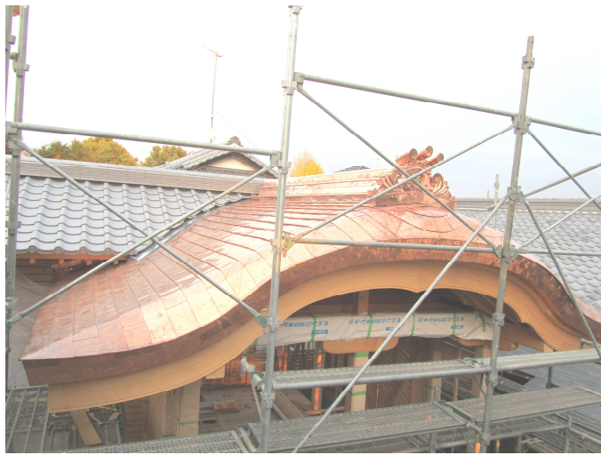
客殿の屋根工事、ほぼ完成しました。 客殿玄関、唐破風の鬼瓦です。
