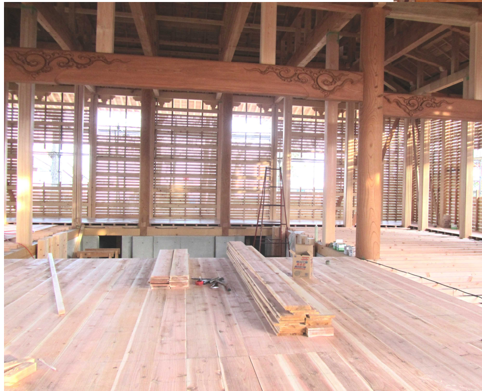
本堂の床板が始まりました。徐々にイメージが湧き、柱や梁が目立ちます、見事です。 窓枠も直に設置されそうです。
